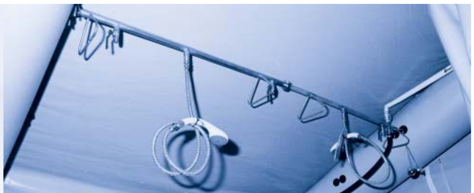
Varillaje con boquillas económicas de agua y duchas manuales.
